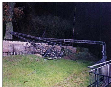
Eine erste Aufnahme noch in der Nacht zeigt deutlich die Zerstörung auf. Nach Ende des Aufbaus im Juli 2017 stand der Mast mal gerade ein gutes Jahr. Die stabilen Stahlrohre der Mastkonstruktion verbogen sich durch die immensen Kräfte wie Gummi. Foto: DL9LBH
