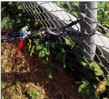
Bild 9: Bodenabspannung mit der durch eine Seilklemme fixierten Umlenkrolle
