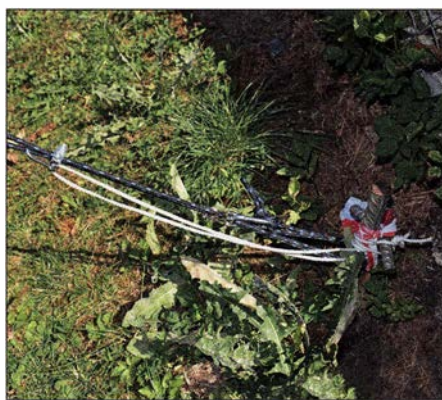
Bild 10: Zusätzliche Sicherung der Umlenkrolle am Abspannhering
