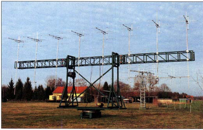
Bild 7: Acht Yagi-Antennen für UKW-Hörrundfunk auf 18 m nebeneinander – sie haben insgesamt nur etwa 10° Öffnungswinkel!
