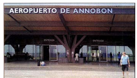
Modernes Flughafengebäude auf der Insel Annobón
